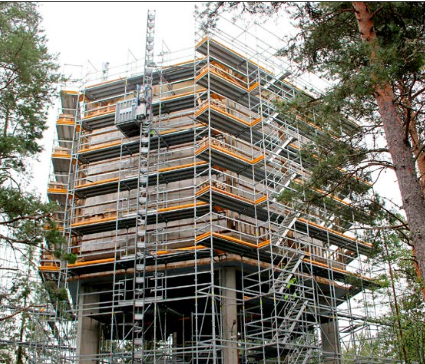
Vesitornia ympäröivät tällä hetkellä rakennustelineet. Sääsuoja nostaa korkeutta vielä hieman lisää.
